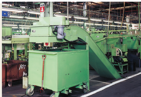
▼機械工場に設置
